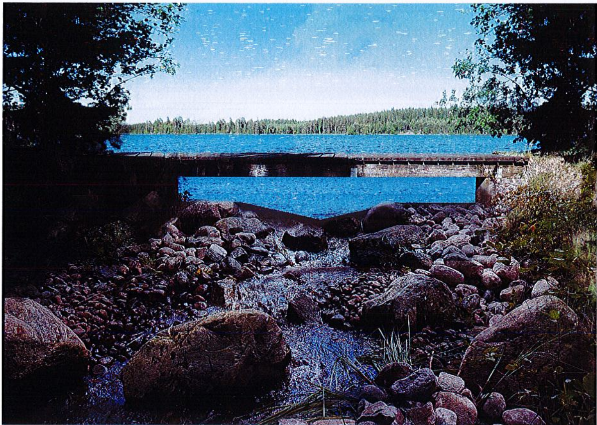
Figur 8. Förslag på ny utformning av utskov, profil 1 inklusive tröskling.
